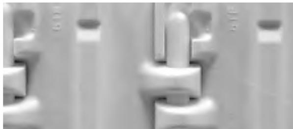
**Figure 200:** Vérifiez que l'axe est inséré au-delà du système de rétention
